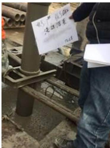
图 1 试桩 GB2 刚浇注完毕效果
