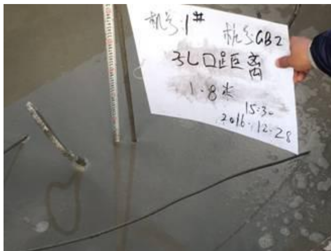
图 2 试桩 GB2 浇注完 50 分钟后效果
