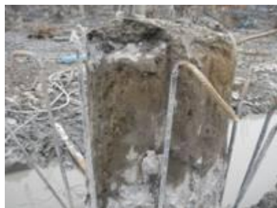
图 4 桩侧泛砂现象
