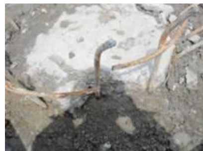
图 5 钢筋周围泛砂现象
